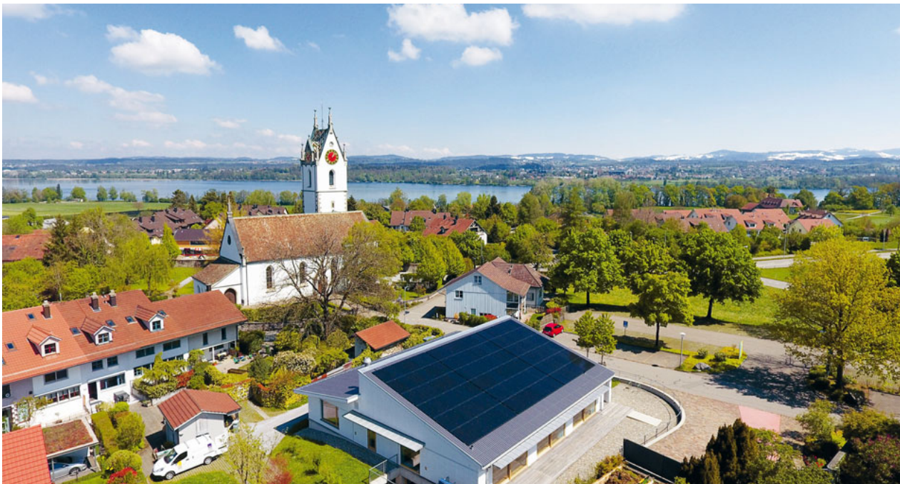
Blick auf das Kirchgemeindehaus Kreuzbühl in Maur: Das neu erstellte Solardach sammelt die Sonnenenergie.
